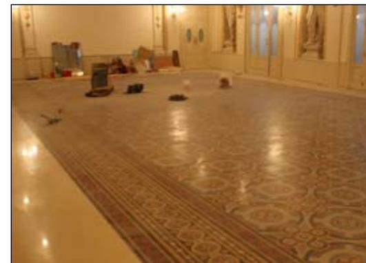
Recupero di 300 metri di pavimentazione in graniglia di marmo del foyer.
