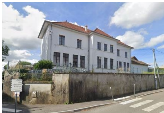
Figura 2: Immagine di Google dell'edificio da ristrutturare nel villaggio di Chimilin
