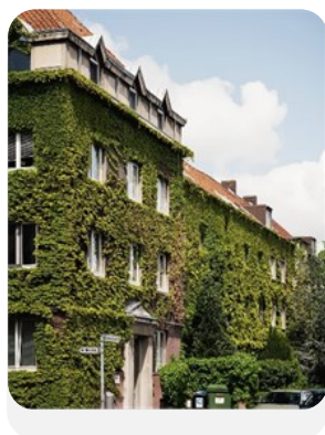
Figura 3.5 - Facciata verde diretta con piante in piena terra (Fonte: DannenbergstraÙe in Hannover – Green Hannover (green-hannover.de) )
