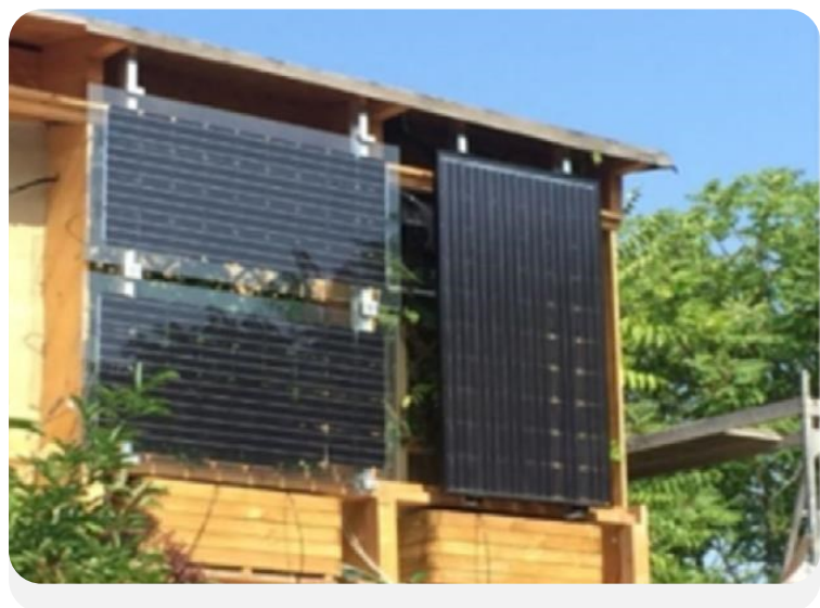
Figura 2.5 - Un esempio di possibile installazione di pannelli fotovoltaici su pareti verdi
