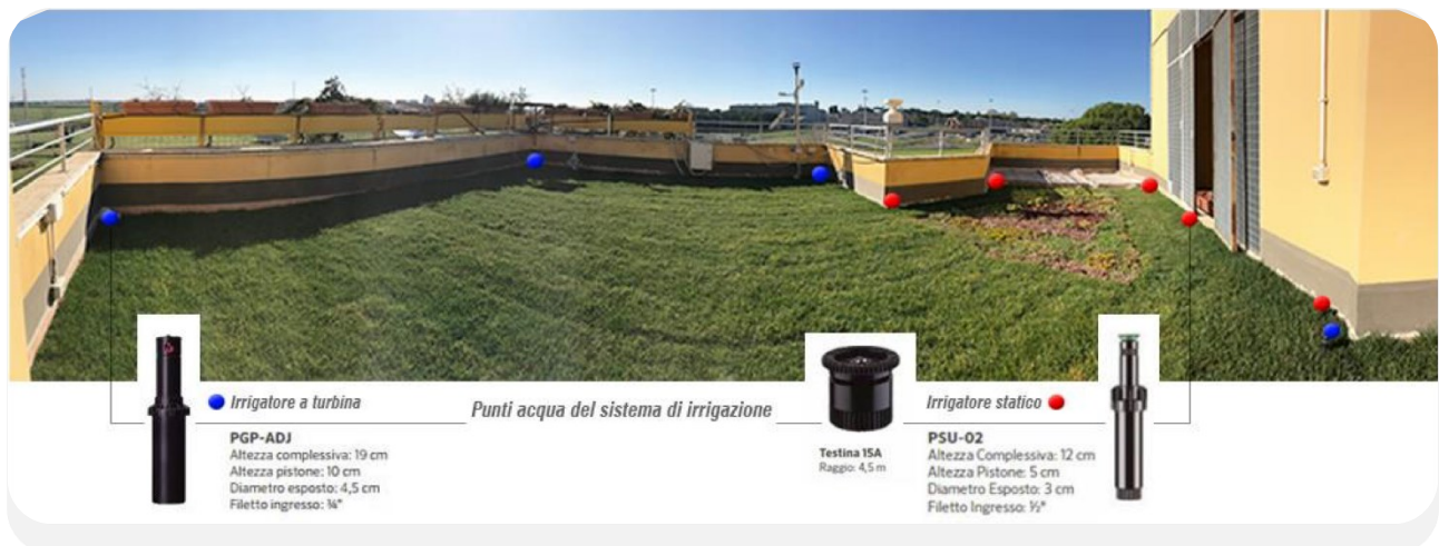
Figura 5.19 - Dettagli del sistema di irrigazione sul tetto verde ENEA, C.R. Casaccia, Roma
