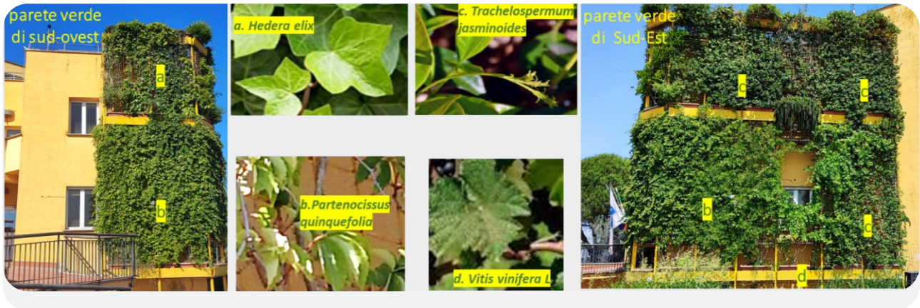
Figura 5.16 - Facciata verde ENEA con il dettaglio delle specie vegetali
