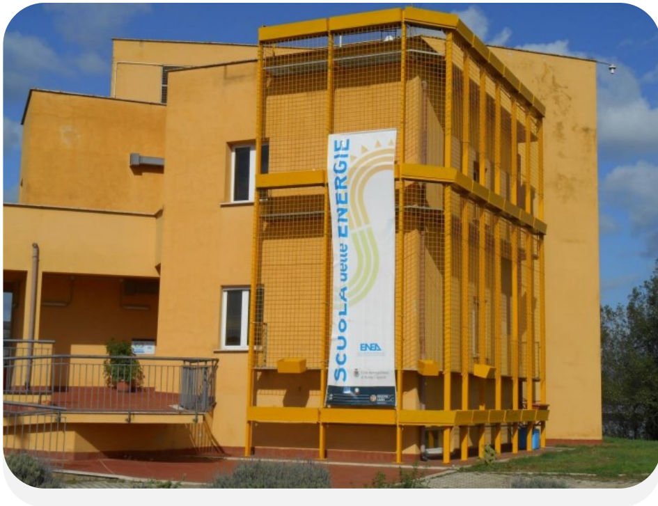
Figura 5.14 - Struttura metallica applicata all'edificio che sorregge la parete verde (Report RdS/PAR2015/141 42 )
